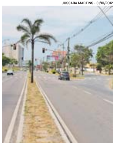
AVENIDA Norte-Sul: distribuição
